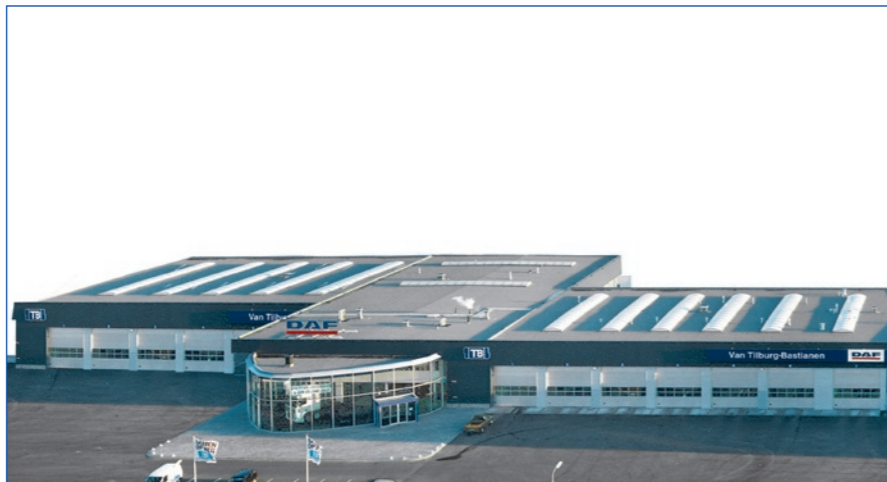
Nieuwbouw (linkergedeelte) DAF Roosendaal
